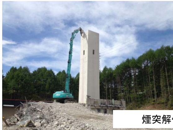
建屋解体作業施工状況
